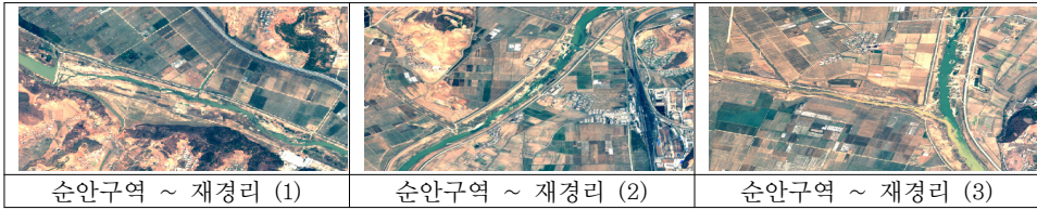
〈그림 4-5〉 1차 연구의 제방복원사업 대상지역의 제방유실 현황
