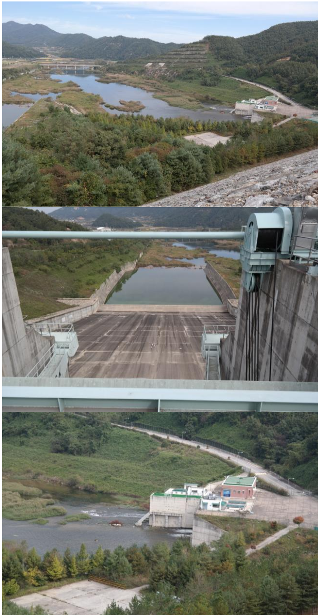
〈그림 2-9〉 용담댐 전면 전경(상단)과 여수로(중간) 및 발전시설(하단) (2013년 10월)
