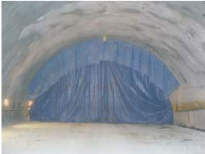
<그림 9-2> 터널발파시 입구에 소음차단 천막 설치
