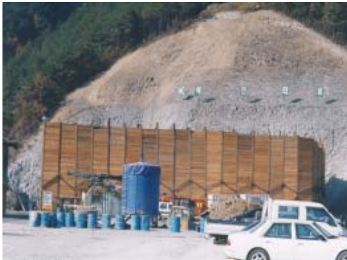
<그림 9-3> 터널발파시 입구에 가설방음판넬 설치
