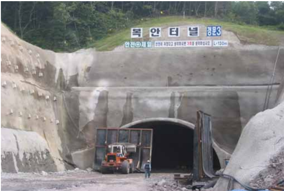
터널발파시 입구에 방음문을 설치하여 발파시 소음저감 〈경부고속철도 12-4공구 복안터널〉
