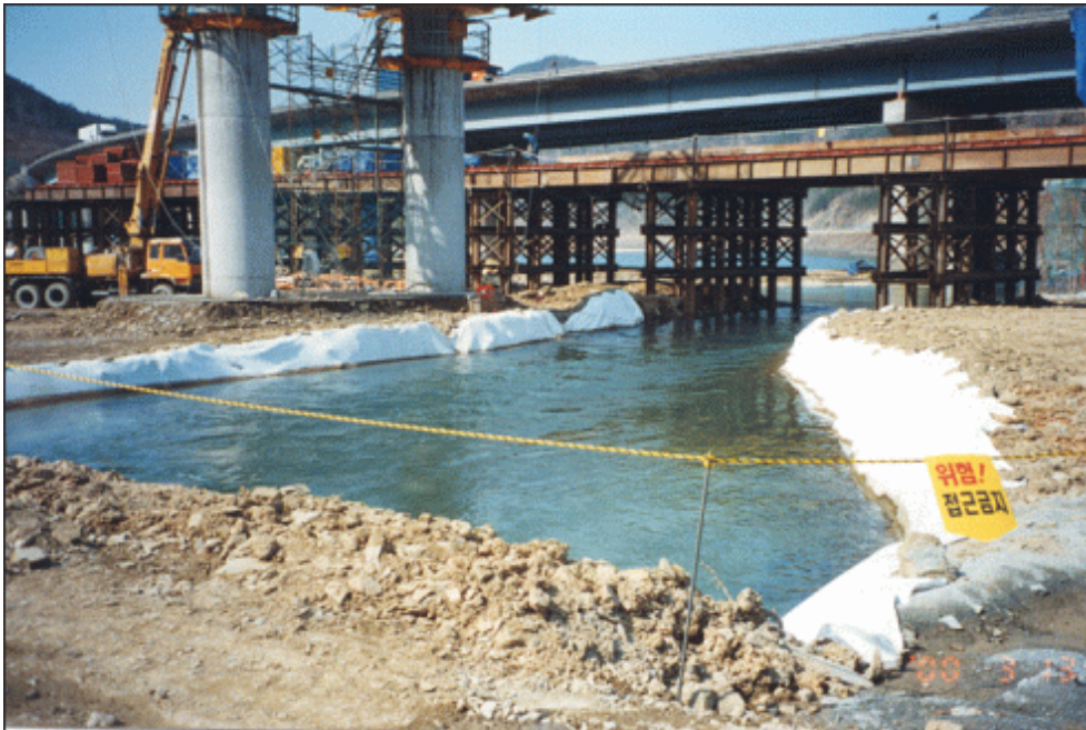
성토면에 부직포 설치하여 토사 유출 방지
