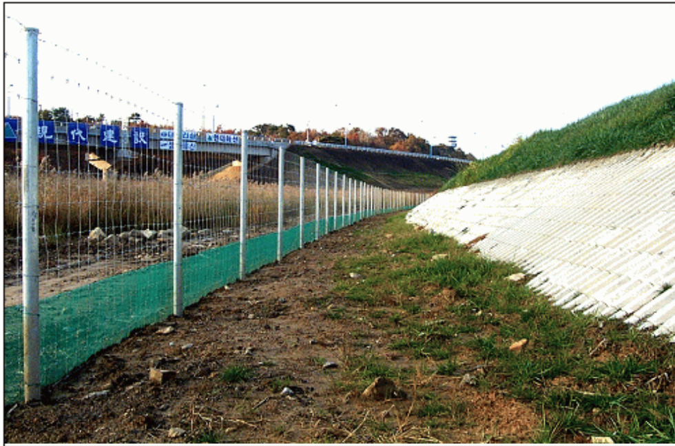
생태이동통로로 동물유도를 위한 울타리 설치 〈동해북부선(저진 ~군사분계선간)〉
