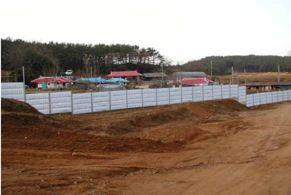
주택근처에서 공사시 가설방음벽 설치하여 소음저감
