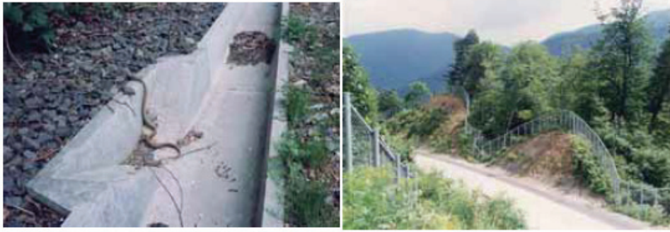
그림 3-17 오니고베 에코로드의 동물 이동 경사로, 유도 펜스
