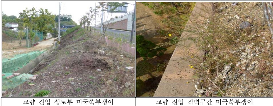
〈그림 3-33〉 국도39호선 우회도로 개설공사지 교량설치부 생태계교란식물 분포 현황
