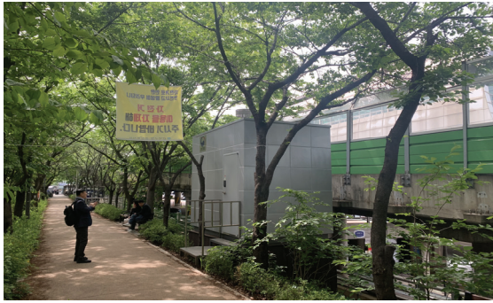
도림천 관측소 설치(4.1)
