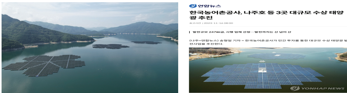
소양강댐 수상태양광 설치 준공('23.11, 양구)
