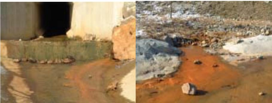
※ 그림 좌측은 최종 배수구에 형성된 유기물질과 누수된 오염물질이며, 그림 우측은 성토사면 하단에서 누수된 오염물질이 수로를 따라 저수지로 유입됨
