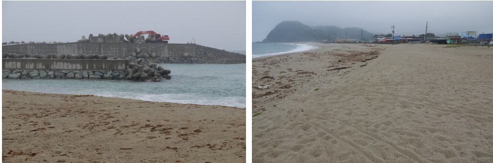
■ 그림 4-24. A군 기성면 기성리 해안(2010년 6월 현재 방파제 공사 중)
