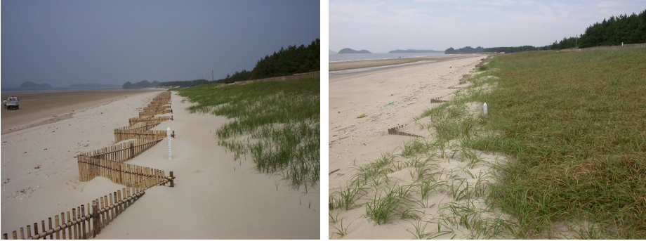
〈그림 2-2-9〉 태안해안국립공원 모래 포집기 시공 후 사구 변화과정
