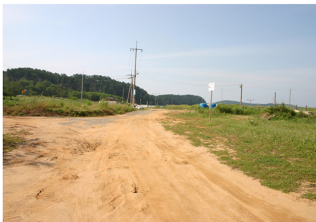
7-4. 사구와 주거지 사이의 방제도로 방치에 의한 훼손(답압, 차량진출입)
