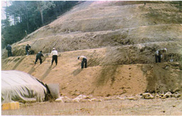
〈그림 2-2-11〉 단끊기 시공 사례
