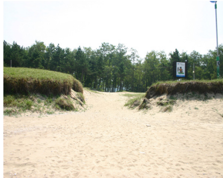
5-2. 화장실 남쪽 진입로 주변부 사구 및 초지 훼손(답압, 사면붕괴)
