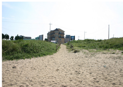
5. 북측 진입로 출구부 사구 및 초지 훼손
