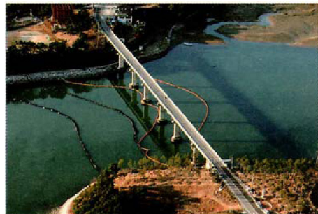
천수만 입구 오일펜스 설치
