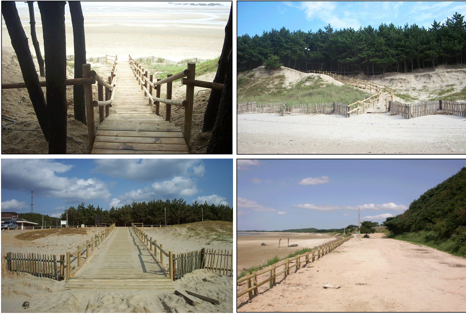
〈그림 2-2-5〉 해안사구 통제시설 설치 사례 (탐방객 유도 및 사구식물 보호 통제 목적(위)과 해안사구 사면보호 목적(아래))
