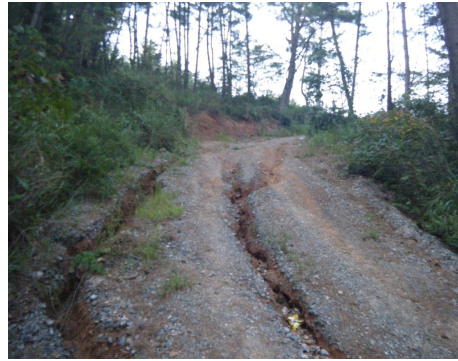
2. 노면 세굴로 세석 및 토사 유실 진행
