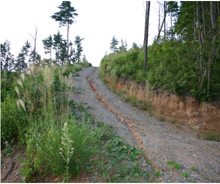
1. 전 구간에 걸친 노면 세굴 및 세석 유실
