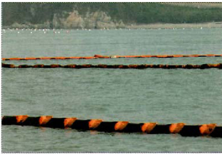
가로림만 입구 오일펜스 설치
