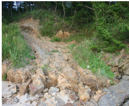
1. 노면 확장에 따른 우측 절토면 붕괴 위험 2. 하단부 측면 절토면 붕괴 및 노면 유실
