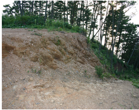
2. 정상부 절토사면 나지 노출로 붕괴 및 침식 진행
