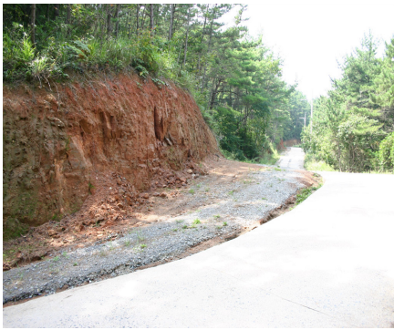
1. 급경사 포장구간 좌측 노면 확장 및 절토구간 노면 세굴 진행
