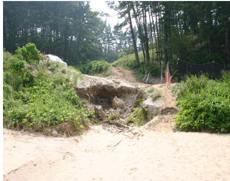
3. 종점부 수로 형성에 따른 세굴 피해
