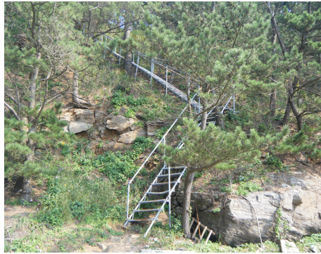
2. 급경사지에 설치된 철제 계단
