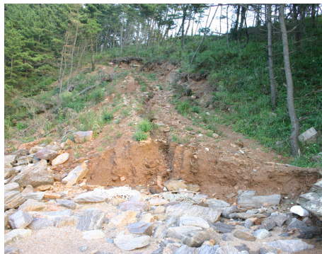
5-2. 해안 인접부 도로 유실
