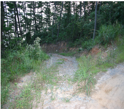
1. 노면 확장에 따른 우측 절토면 붕괴 위험 2. 하단부 측면 절토면 붕괴 및 노면 유실
